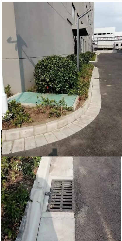
项目区排水系统
