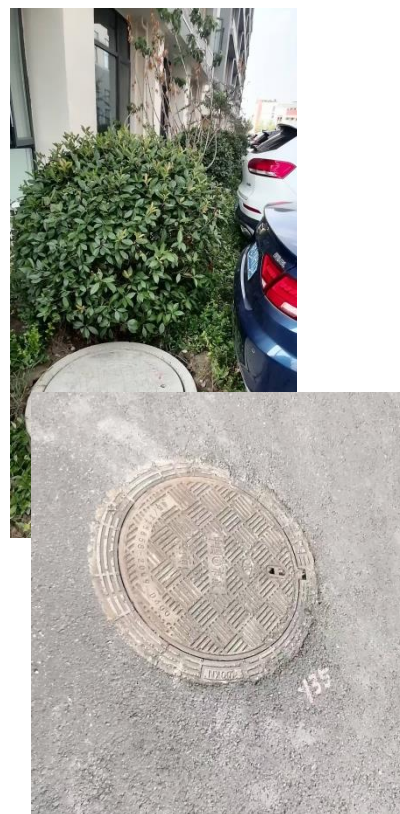
项目区排水系统
